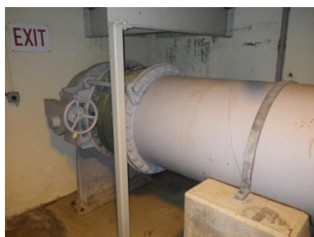
Biotower effluent pipe
